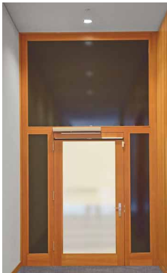
T30 RS-1, Oberlichthöhe 1600 mm. Türelement links, rechts und oben verdeckt durch Einbauten, deshalb Glas in lackiert
