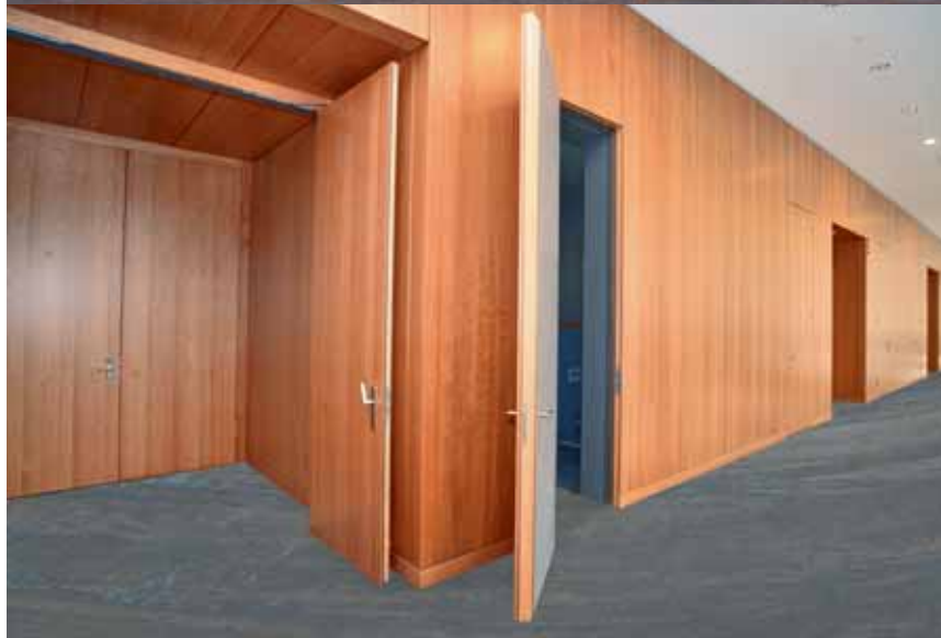
Bürozugangstüren mit integriertem Freilaufschließer und verdecktem Kabelübergang
