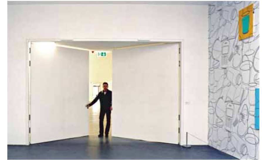
Enorme Abmessungen: Brandschutztür T 30 mit Flügelbreite 2200 mm im Hans-Arp-Museum in Rolandseck
