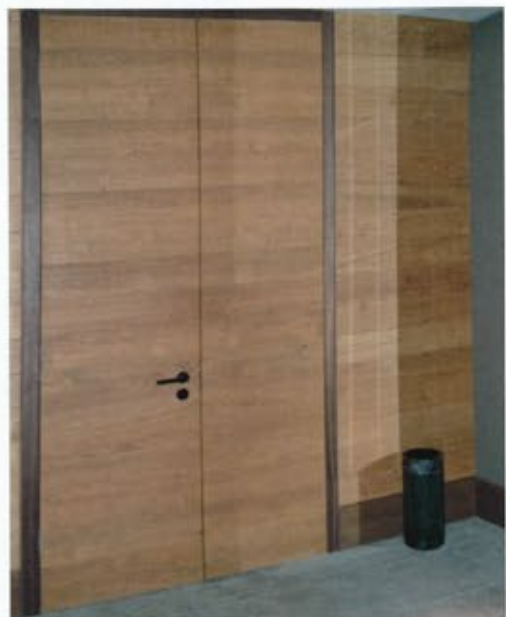
Eine von 112 Zimmereingangstüren, flächenbündig zimmer- und flurseitig ausgeführt (Foto: GHM, Reto Guntli)
