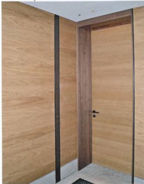
Eine von 135 Flurtüren, horizontal in Wildeiche furniert (Foto: GHM, Reto Guntli)
